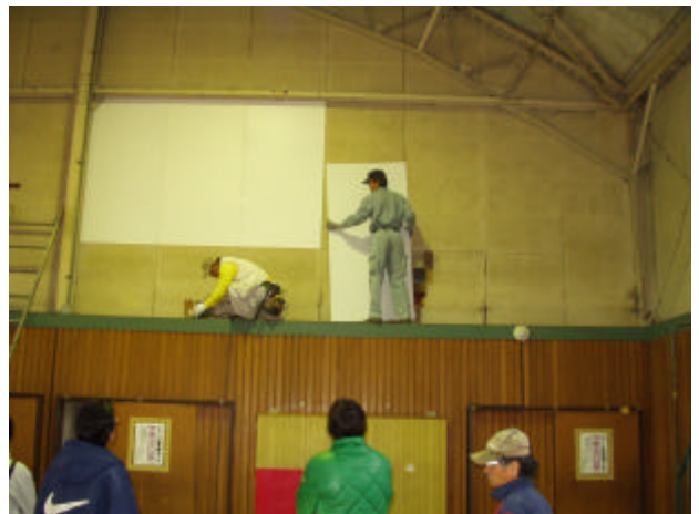
<写真 修繕作業風景>
